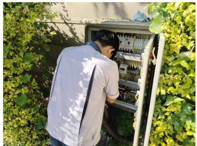
ช่างอาคารฯ ตรวจสอบเช็คระบบเตือนภัยน้ำท่วม (ตามแผนงาน)
