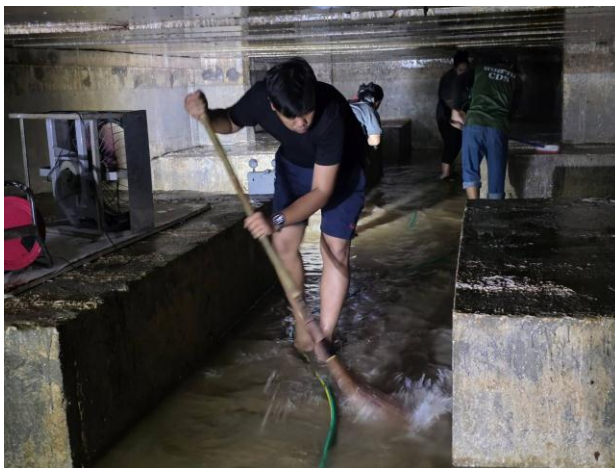
ช่างอาคารฯ ดำเนินการล้างแทงค์น้ำชั้นใต้ดินและชั้นดาดฟ้า อาคาร A B และอาคาร C
