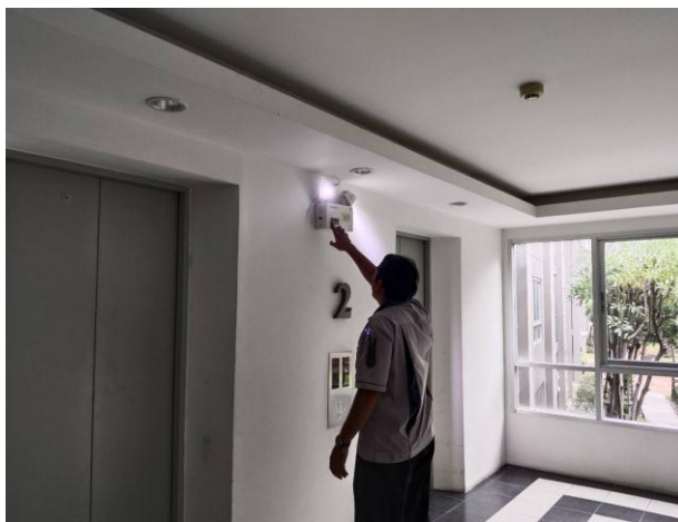
ช่างอาคารฯ ดำเนินการตรวจสอบเช็คระบบไฟฉุกเฉิน (Emergency light) (ตามแผนงาน)
