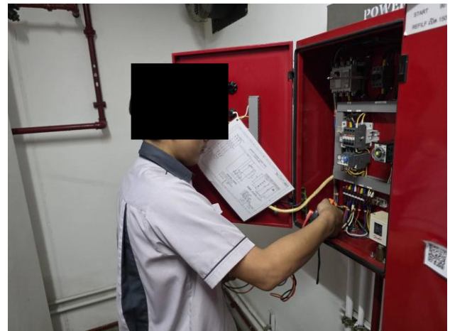
ช่างอาคารฯ ตรวจสอบการทำงานของระบบดับเพลิง (ตามแผนงานประจำเดือน)
