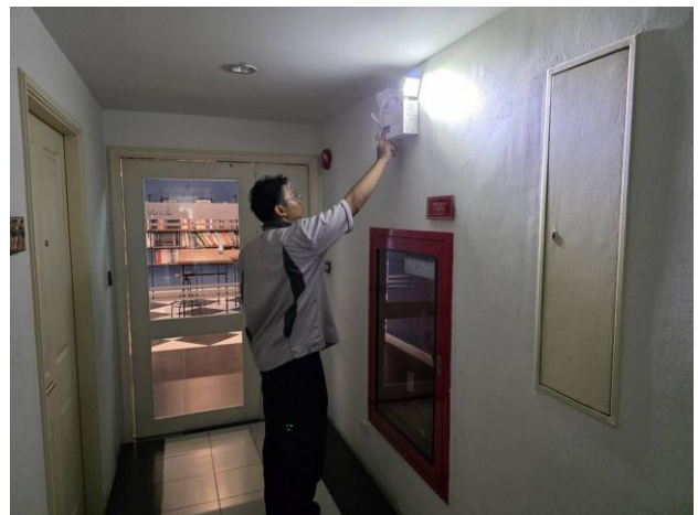
ช่างอาคารฯ ดำเนินการตรวจสอบใช้ระบบไฟฉุกเฉิน (Emergency light) (ตามแผนงาน)
