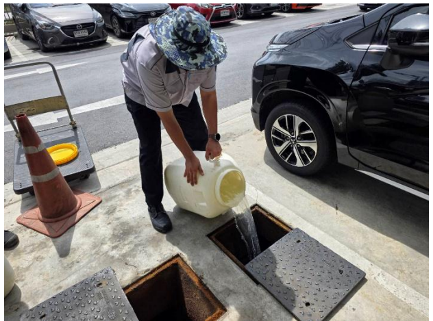
ช่างอาคารฯ ดำเนินการเติมจุลินทรีย์ บริเวณบ่อบำบัดน้ำเสีย อาคาร A B และอาคาร
