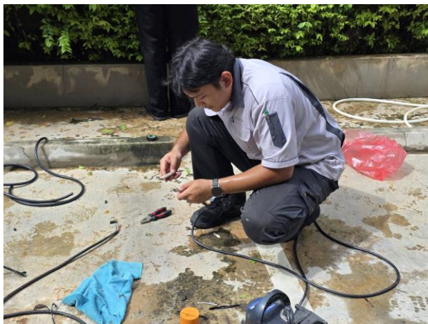
ช่างอาคารฯ ดำเนินการแก้ไขปั๊มบ่อบำบัดบริเวณอาคาร A เนื่องจากสายไฟชำรุด
