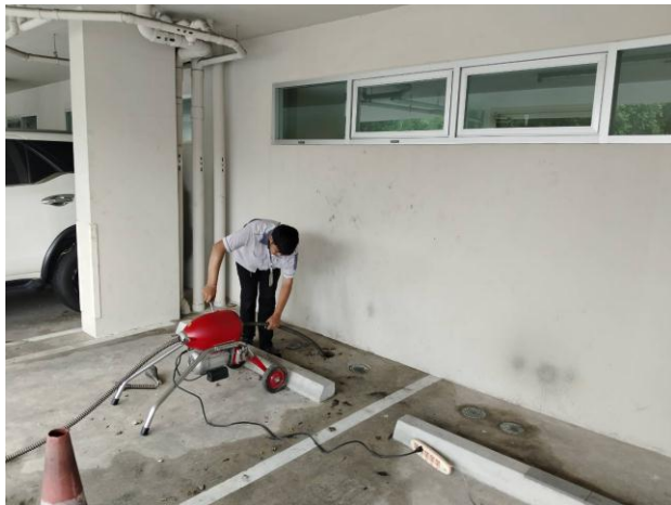
ช่างอาคารฯ ดำเนินการแก้ไขท่อน้ำทิ้งบริเวณอาคาร A เนื่องจากน้ำไม่ระบาย
