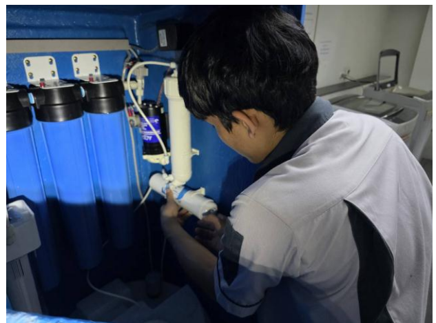
ช่างอาคารฯ ดำเนินการเปลี่ยนไส้กรองตู้กดน้ำดื่มอาคาร A B และ C
