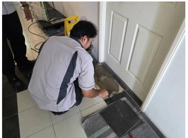
ช่างอาคารฯ ดำเนินการแก้ไขกระเบื้องที่ชำรุดบริเวณชั้นพักอาศัยอาคาร A ชั้น 4
