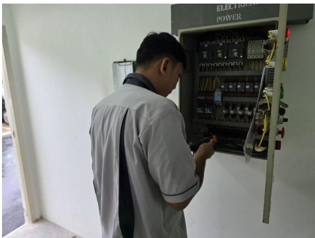
ช่างอาคารฯ ตรวจสอบระบบ Transfer pump อาคาร A B และอาคาร C (ตามแผนงาน)
