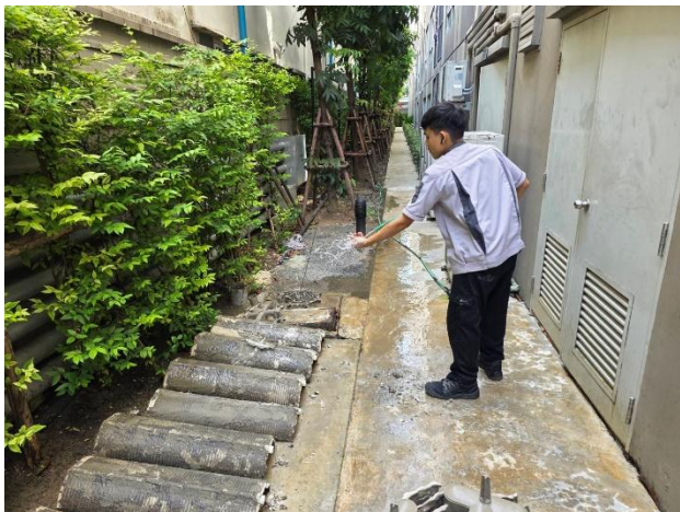
ช่างอาคารฯ ดำเนินการล้างกรองสระว่ายน้ำน้ำ (ตามแผนงานประจำเดือน)
