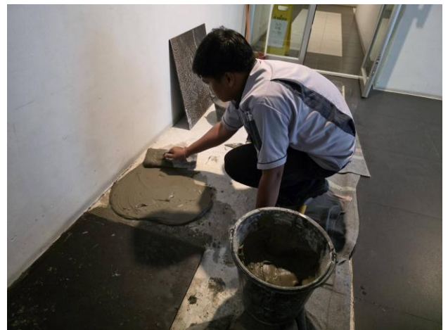
ช่างอาคารฯ ดำเนินการแก้ไขกระเบื้องที่ชำรุดบริเวณหน้าทางเข้าโถงลิฟต์อาคาร B
