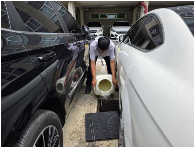
ช่างอาคารฯ ดำเนินการเติมจุลินทรีย์ บริเวณบ่อบำบัดน้ำเสีย อาคาร A B และอาคาร
