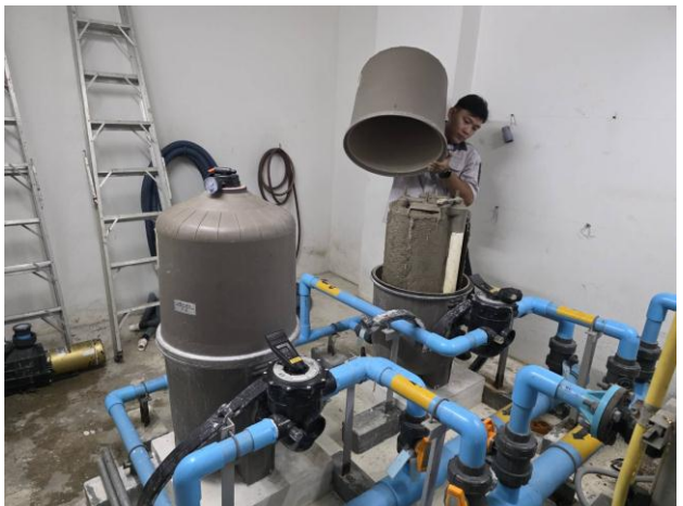
ช่างอาคารฯ ดำเนินการล้างกรองสระว่ายน้ำ (ตามแผนงานประจำเดือน)
