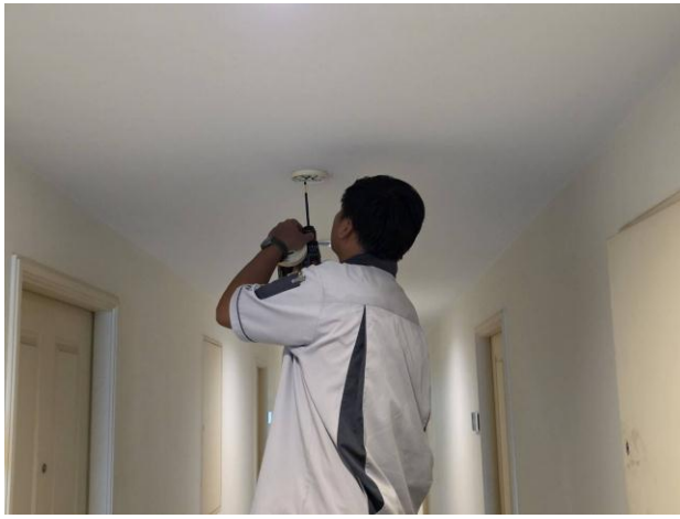
ช่างอาคารฯ ดำเนินการเปลี่ยนอุปกรณ์จับควัน ( Smoke Detector ) ที่ชำรุด อาคาร A B และ C
