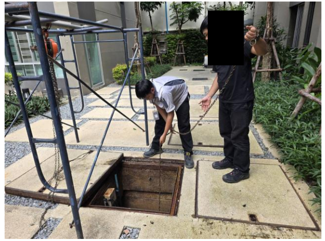
ช่างอาคารฯ ดำเนินการแก้ไขป้มเติมอากาศบริเวณอาคาร C เนื่องจากเบรกเกอร์ทริป
