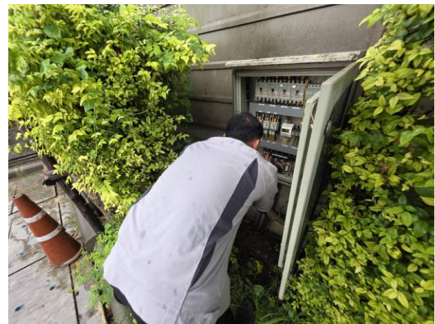
ช่างอาคารฯ ตรวจสอบระบบเดรนปั๊มป้องกันน้ำท่วม (ตามแผนงาน)
