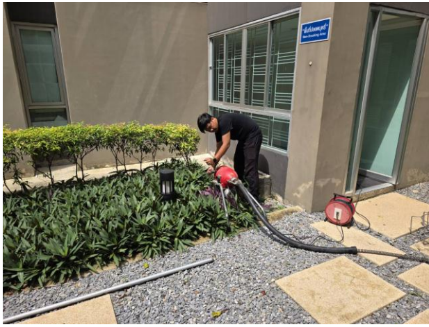
ช่างอาคารฯ ดำเนินการแก้ไขท่อน้ำทิ้งบริเวณอาคาร B เนื่องจากน้ำไม่ระบาย
