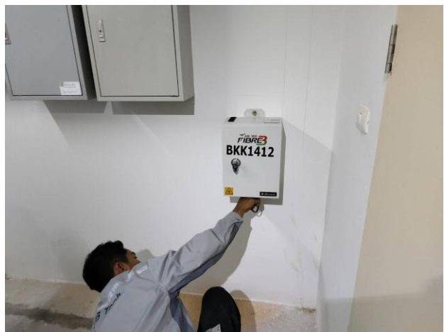
ผู้รับเหมาเข้าดำเนินการติดตั้งตู้อุปกรณ์รับ-ส่งสัญญาณ Fiber Optic อาคาร A B และอาคาร C
