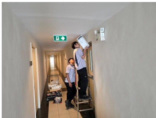
ช่างอาคารฯ ดำเนินการเปลี่ยนแบตเตอรี่ไฟฉุกเฉิน (Emergency Light) และป้ายไฟ Exit
