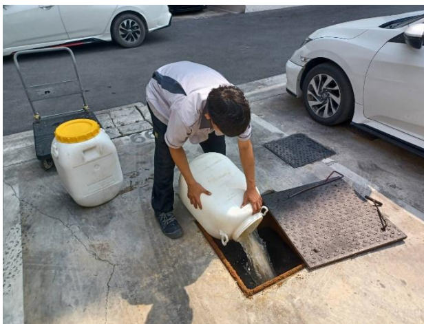
ช่างอาคารฯ ดำเนินการเติมจุลินทรีย์ บริเวณบ่อบำบัดน้ำเสีย อาคาร A B และอาคาร C
