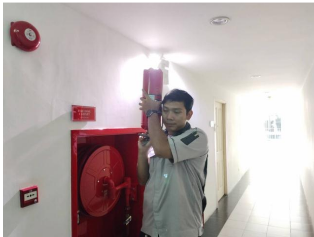
ช่างอาคารฯ ดำเนินการตรวจสอบเช็คถังดับเพลิง (ตามแผนงาน)
