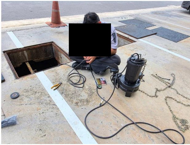
ช่างอาคารฯ ดำเนินการแก้ไขปั๊มเติมอากาศบริเวณอาคาร C เนื่องจากขดลวดไหม้
