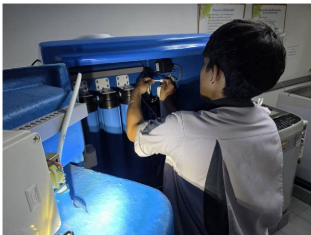
ช่างอาคารฯ ดำเนินการเปลี่ยนไส้กรองตู้กดน้ำดื่มอาคาร A B และ C
