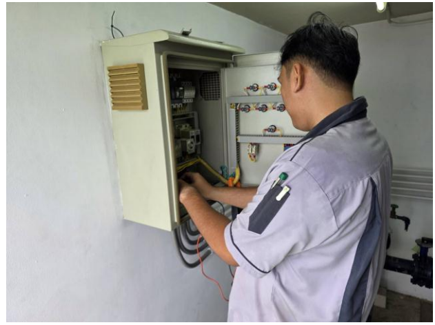
ช่างอาคารฯ ตรวจสอบเช็คระบบ Booster pump อาคาร A B และอาคาร C (ตามแผนงาน)
