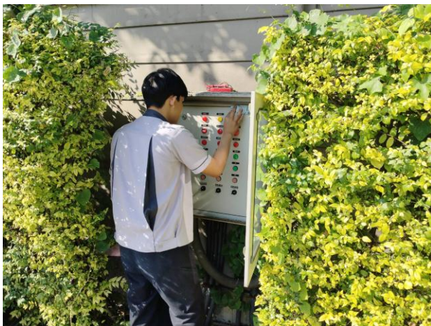
ช่างอาคารฯ ตรวจสอบระบบเตรนปั้มบ่อน้ำทิ้งโครงการ (ตามแผนงาน)
