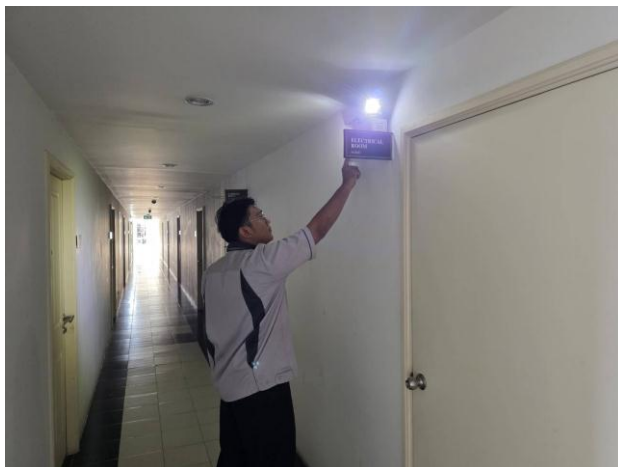
ช่างอาคารฯ ดำเนินการตรวจสอบใช้ระบบไฟฉุกเฉิน (Emergency light) (ตามแผนงาน)
