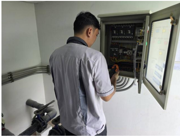
ช่างอาคารฯ ตรวจสอบใช้ระบบ Booster pump อาคาร A B และอาคาร C (ตามแผนงาน)
