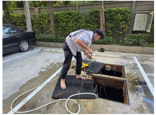
ช่างอาคารฯ ดำเนินการล้างทำความสะอาดบ่อบำบัดอาคาร B
