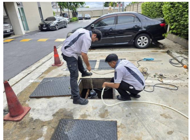
ช่างอาคารฯ ดำเนินการแก้ไขปั๊มบ่อบำบัดบริเวณอาคาร A เนื่องจากสายไฟชำรุด
