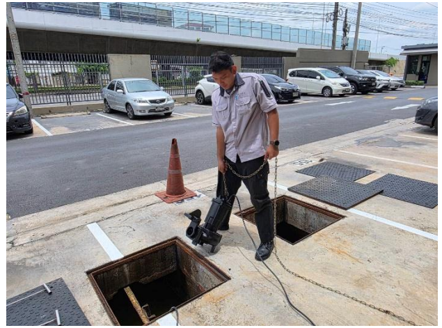
ช่างอาคารฯ ดำเนินการแก้ไขปั๊มเติมอากาศบริเวณอาคาร C เนื่องจากขดลวดไหม้
