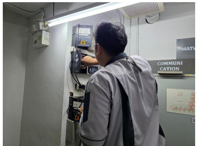
ช่างอาคาร ฯ ดำเนินการเปลี่ยน power supply ที่ชำรุด บริเวณประตูเข้า ออกอาคาร ชั้น 1 อาคาร C
