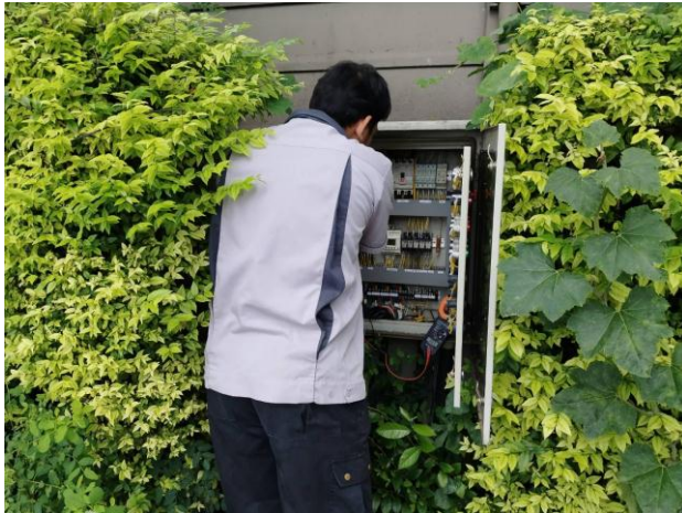
ช่างอาคารฯ ตรวจสอบใช้ระบบเดรนปั๊มป้องกันน้ำท่วมอาคาร (ตามแผนงาน)
