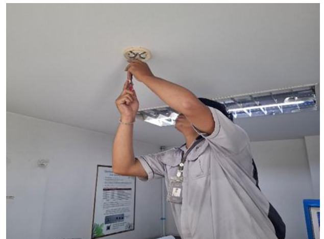
ช่างอาคารฯ ดำเนินการเปลี่ยนอุปกรณ์ตัวจับควัน (Smoke Detector) อาคาร A B และอาคาร C
