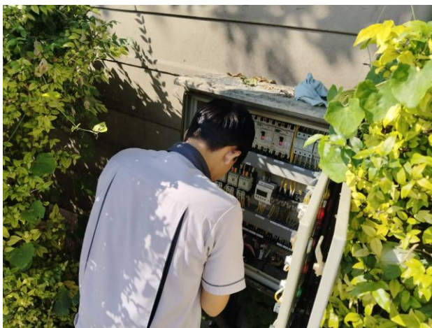
ช่างอาคารฯ ตรวจสอบเช็คระบบเตือนภัยน้ำท่วม (ตามแผนงาน)
