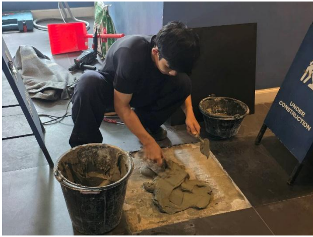
ช่างอาคารฯ ดำเนินการแก้ไขกระเบื้องที่ชำรุดบริเวณหน้าโถงลิฟต์ อาคาร A
