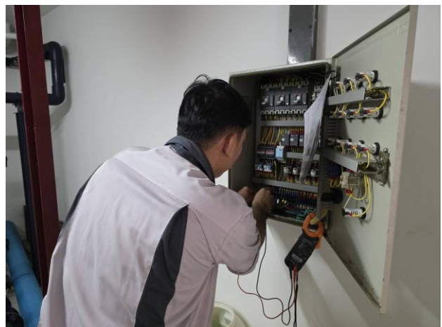
ช่างอาคารฯ ตรวจสอบระบบ Transfer pump อาคาร A B และอาคาร C (ตามแผนงาน)
