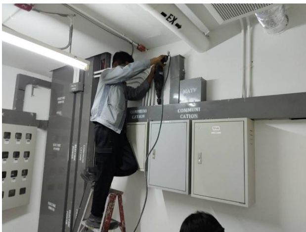
ผู้รับเหมาเข้าดำเนินการติดตั้งตู้อุปกรณ์รับ-ส่งสัญญาณ Fiber Optic อาคาร A B และอาคาร C
