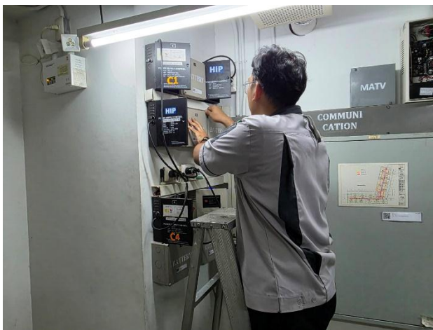
ช่างอาคาร ฯ ดำเนินการเปลี่ยน power supply ที่ชำรุด บริเวณประตูเข้า ออกอาคาร ชั้น 1 อาคาร C
