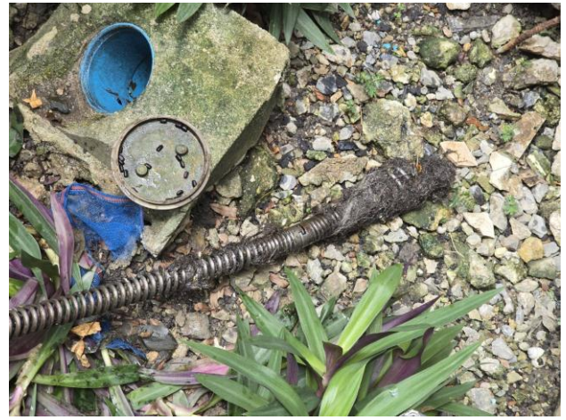
ช่างอาคารฯ ดำเนินการแก้ไขท่อน้ำทิ้งบริเวณอาคาร B เนื่องจากน้ำไม่ระบาย
