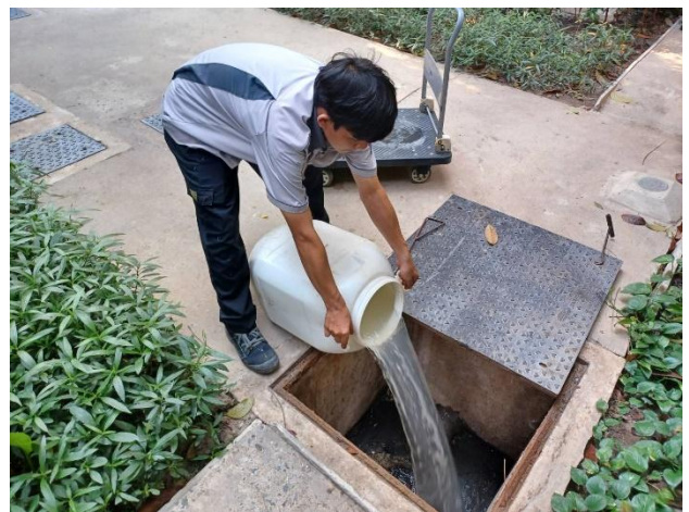
ช่างอาคารฯ ดำเนินการเติมจุลินทรีย์ บริเวณบ่อบำบัดน้ำเสีย อาคาร A B และอาคาร C
