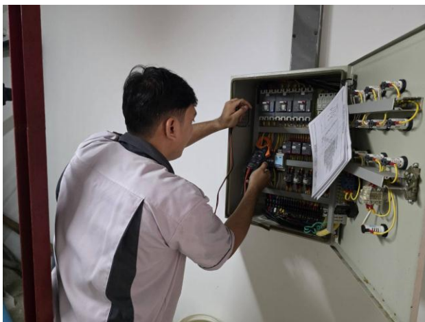
ช่างอาคารฯ ตรวจสอบใช้ระบบ Transfer pump อาคาร A B และอาคาร C (ตามแผนงาน)
