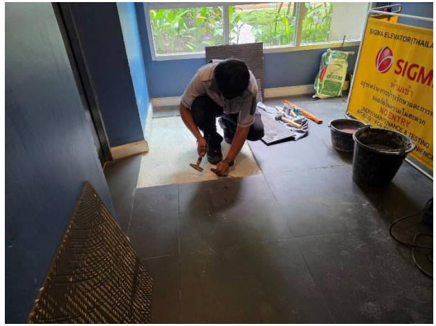
ช่างอาคารฯ ดำเนินการแก้ไขกระเบื้องที่ชำรุดบริเวณหน้าโถงลิฟต์ อาคาร A
