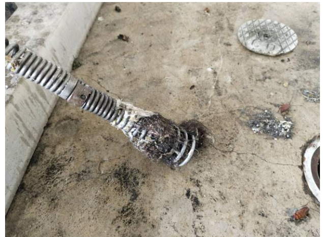
ช่างอาคารฯ ดำเนินการแก้ไขท่อน้ำทิ้งบริเวณอาคาร A เนื่องจากน้ำไม่ระบาย
