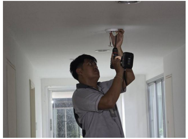
ช่างอาคารฯ ดำเนินการเปลี่ยนอุปกรณ์จับควัน ( Smoke Detector ) ที่ชำรุด อาคาร A B และ C
