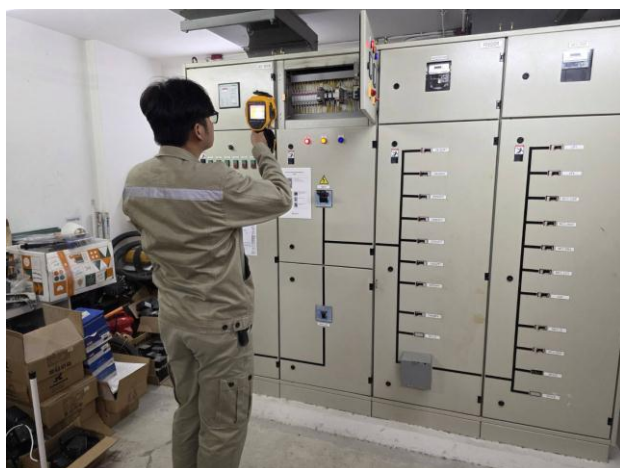
เจ้าหน้าที่การไฟฟ้าเข้าดำเนินการบำรุงรักษาเชิงป้องกัน (Preventive Maintenance) หม้อแปลงและตู้ควบคุมไฟฟ้าหลักในอาคาร (MDB)
