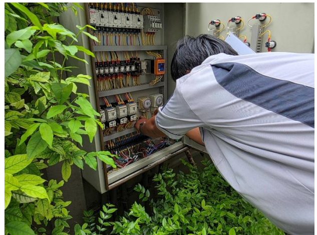
ช่างอาคารฯ ดำเนินการเปลี่ยนไทม์เมอร์ (Timer) ระบบบ่อบำบัดน้ำเสีย
